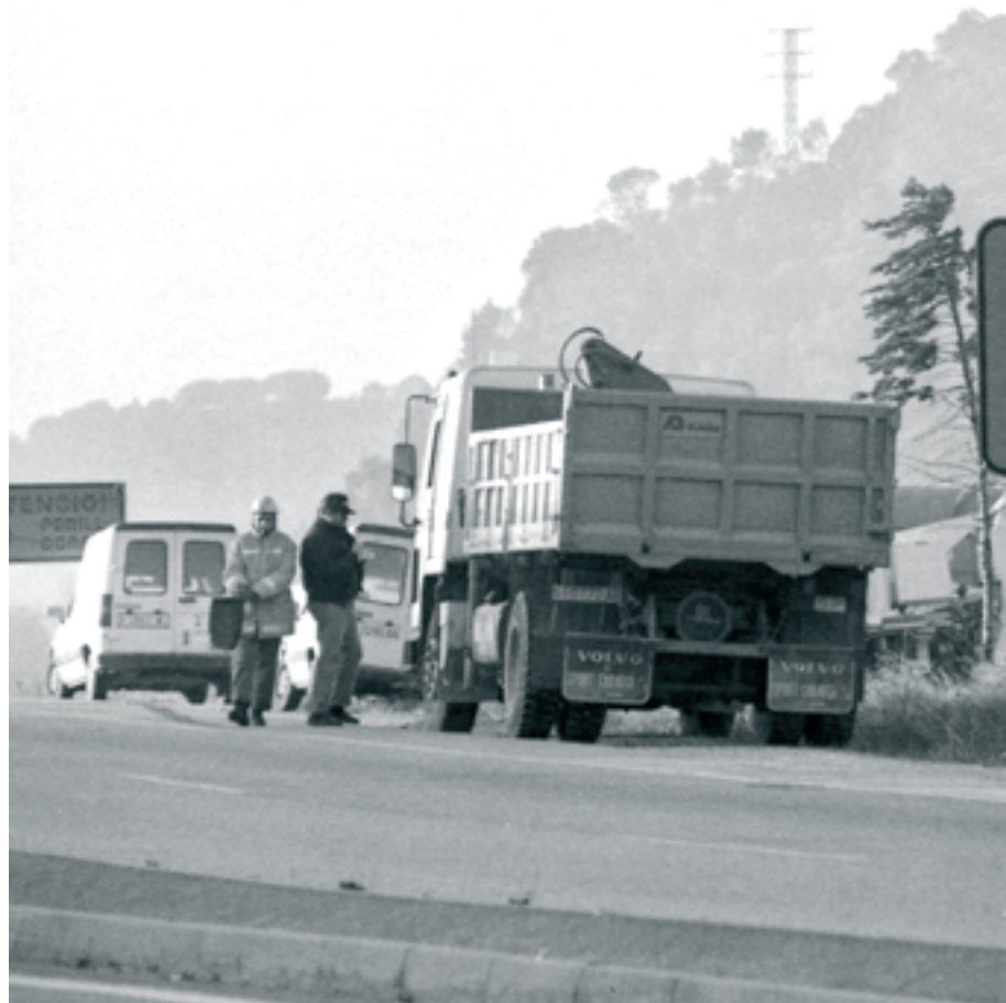
Els treballs per construir els separadors a l'autovia de l'Ametlla de l'any 1994
