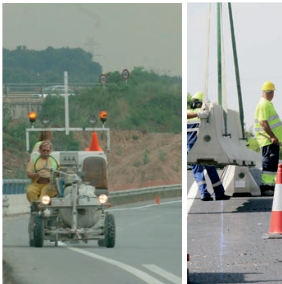
A l'esquerra, un operari repinta línies a la variant de Cardedeu. A la dreta, operaris instal·len separadors
