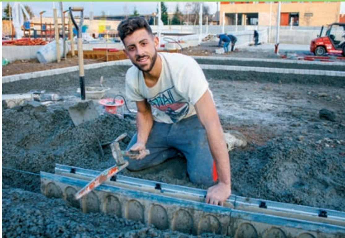
Campayo, aquest dijous a la tarda, en una obra a Manlleu
