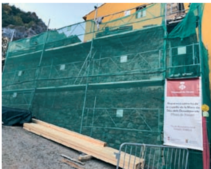
Imatge de les obres de la coberta
