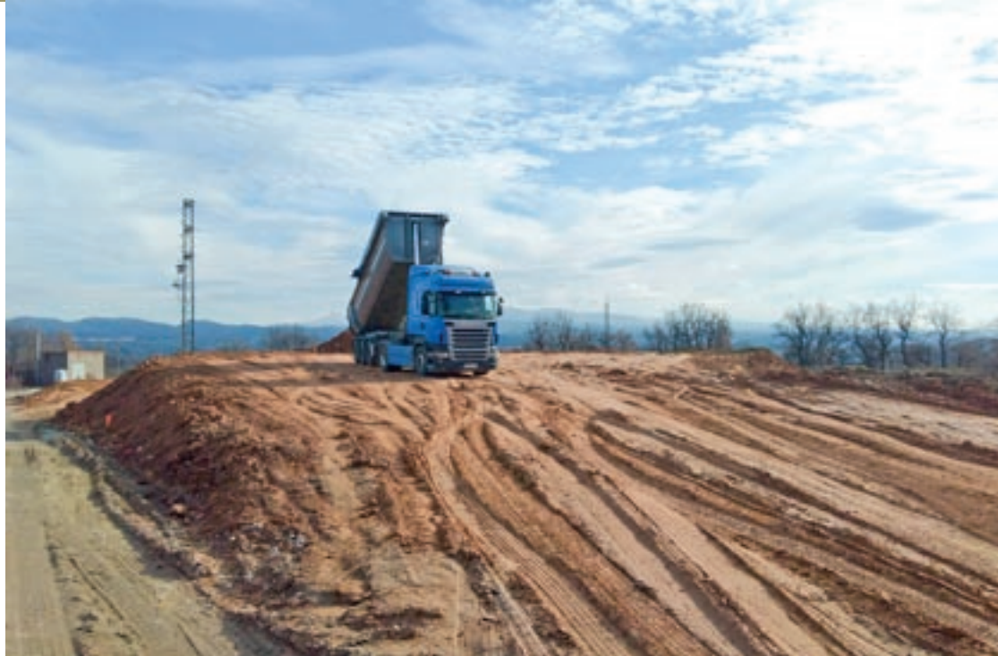
Un camió treballant en el terreny que havia ocupat el dipòsit de fangs de la depuradora de Vic
