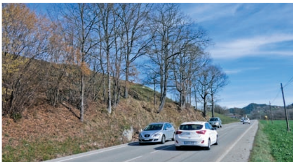
Els roures de l'esquerra de la carretera estan ara afectats pel nou carril de la via verda que es vol fer
