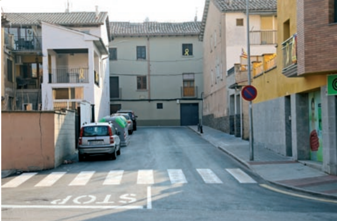
El punt on el carrer Puigdasalit desemboca al carrer Nou, amb l’edifici que es vol enderrocar al fons
