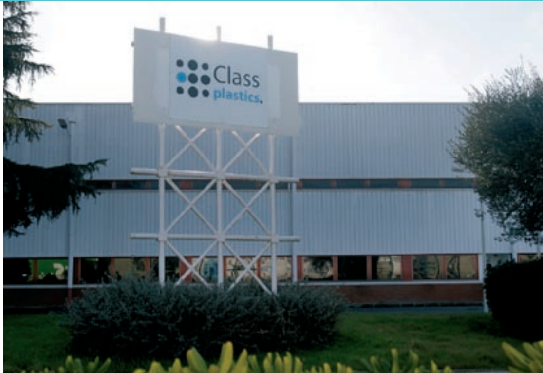
Instal·lacions de Class Plastics, a l'antiga fàbrica del grup Valeo a Martorelles
