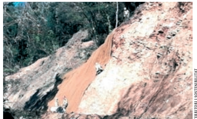
Operaris instal·lant geomalla en un dels punts malmesos
