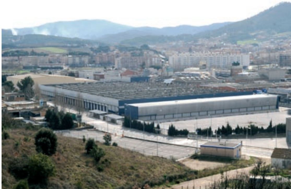
Un aspecte de les àmplies instal·lacions que Henkel té a Montornès
