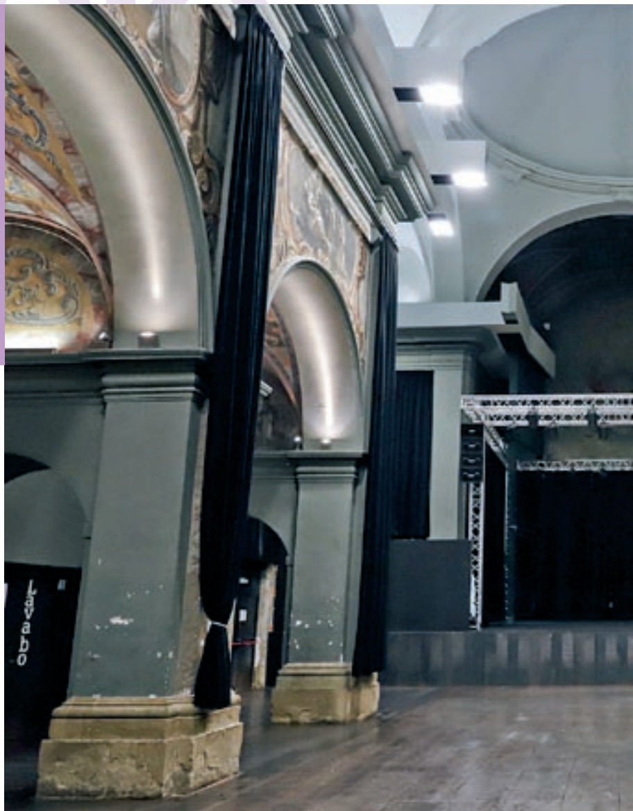
Imatge actual de la nau central de l'equipament, amb alguns signes visibles del pas del temps. L'
