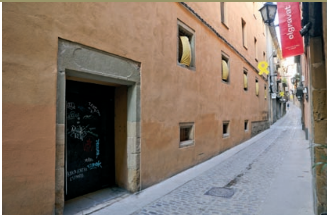
Façana del Seminari Vell pel carrer Sant Miquel. No va prosperar el projecte de fer-hi un complex residencial universitari
