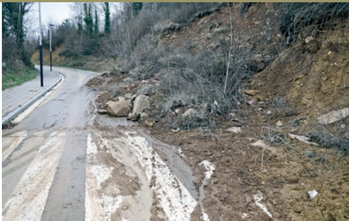
Imatge d'aquest dimarts de l'estat de la urbanització de la Torre de Ripoll
