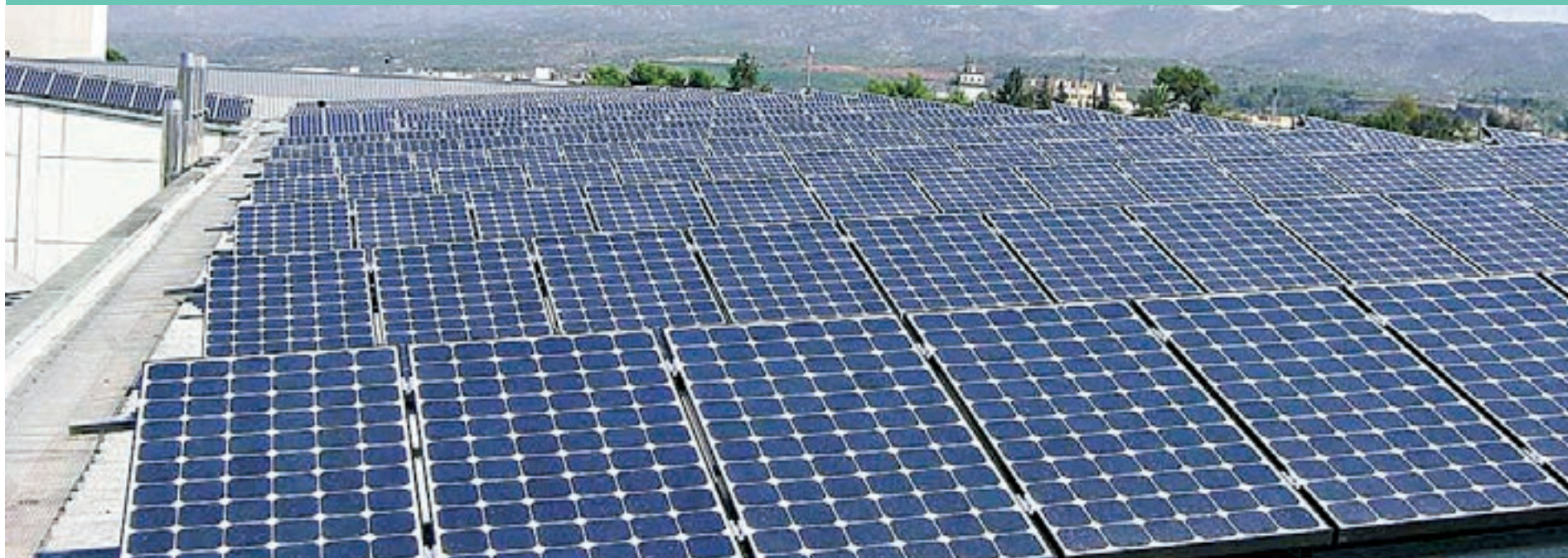
Una de les instal·lacions més grans de plaques d'autoconsum, en una empresa del Baix Ebre per part de Sud Renovables
