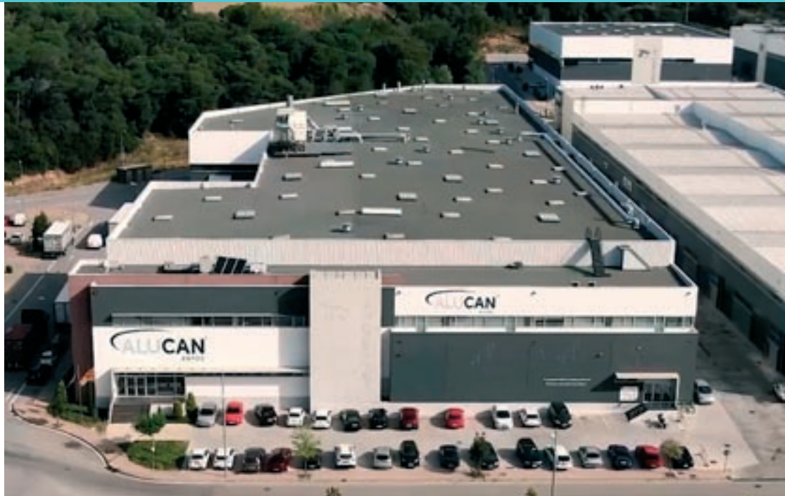
Les instal·lacions de Llinars que l'empresa Alucan va posar en funcionament l'any 2016
