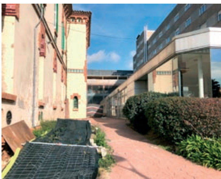
Al fons de la imatge, les obres aturades de les noves instal·lacions
