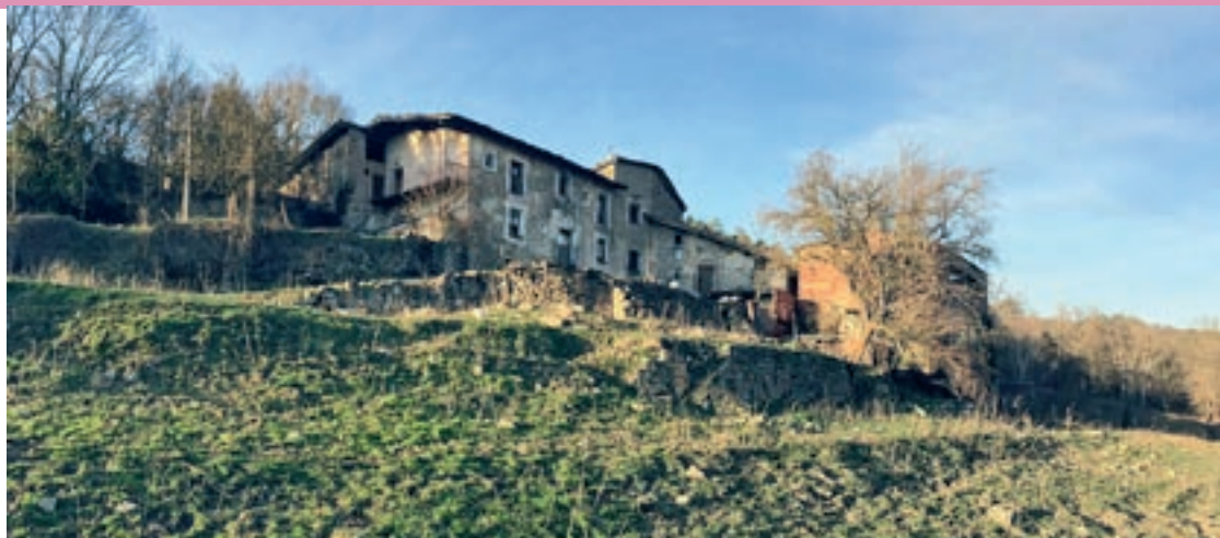
Vista parcial de la històrica masia, actualment en fase de restauració
