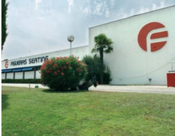
Les instal·lacions de Figueras International Seating a Lliçà d'Amunt
