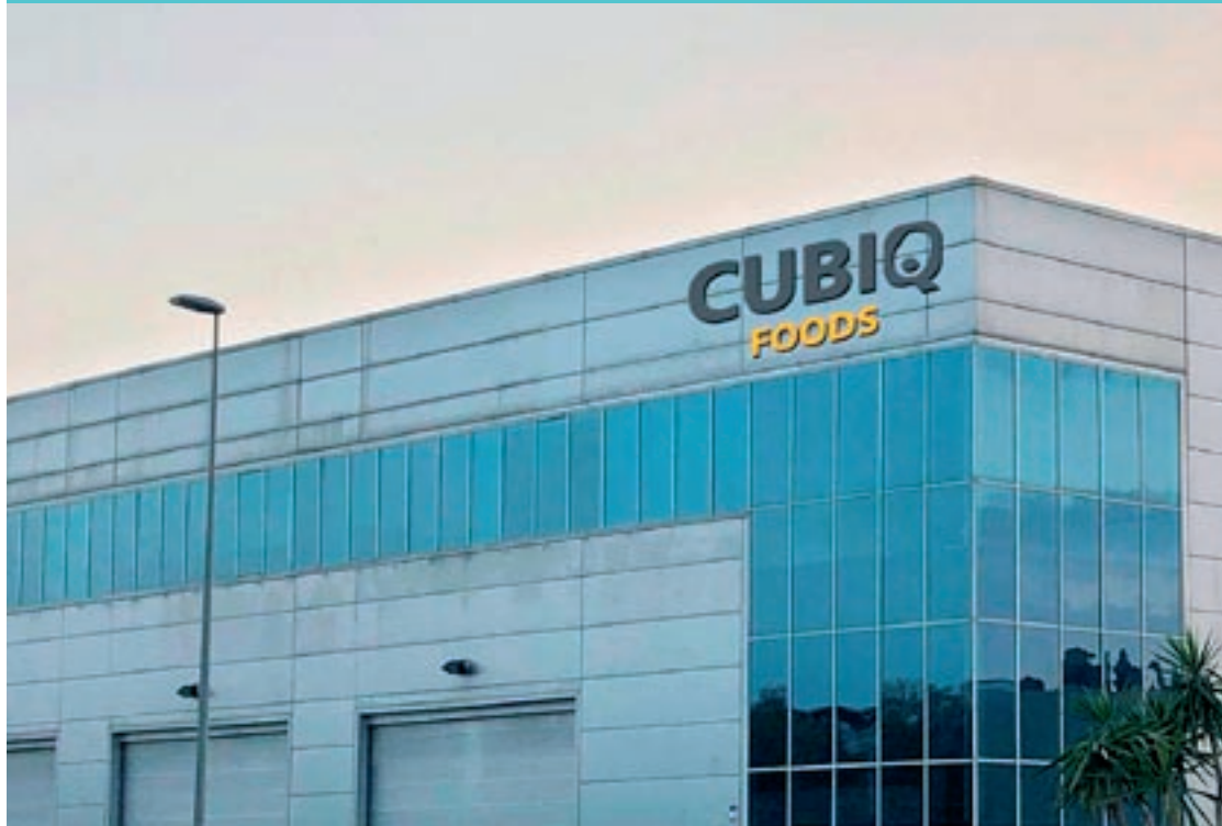
L'empresa opera des d'una nau de 4.000 metres quadrats al polígon industrial de Palou Nord, a Granollers
