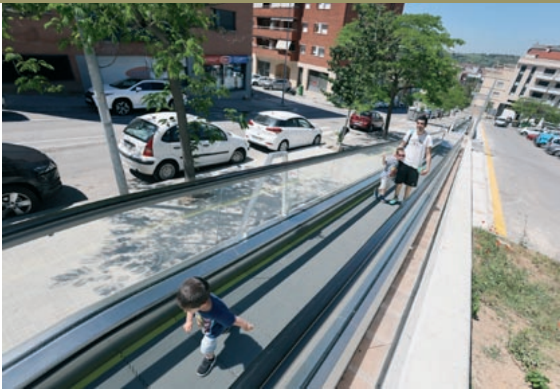
L'obra civil havia acabat abans de final d'any però el procés de connexió elèctrica ha endarrerit la posada en marxa
