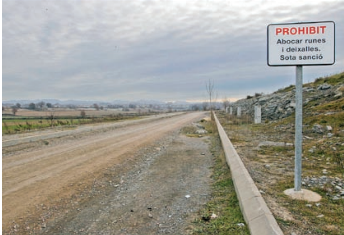
Vista del carrer de Mas Pons de Calldetenes, un dels que forma part del Torrental
