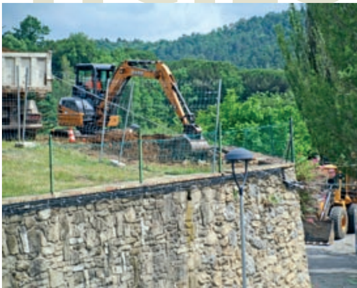
La maquinària treballant a l'espai on es farà la Secundària
