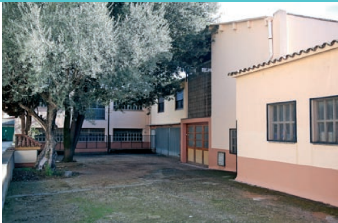
Aquest és l'edifici, a 150 metres del centre de La Salle, on es farà el laboratori industrial
