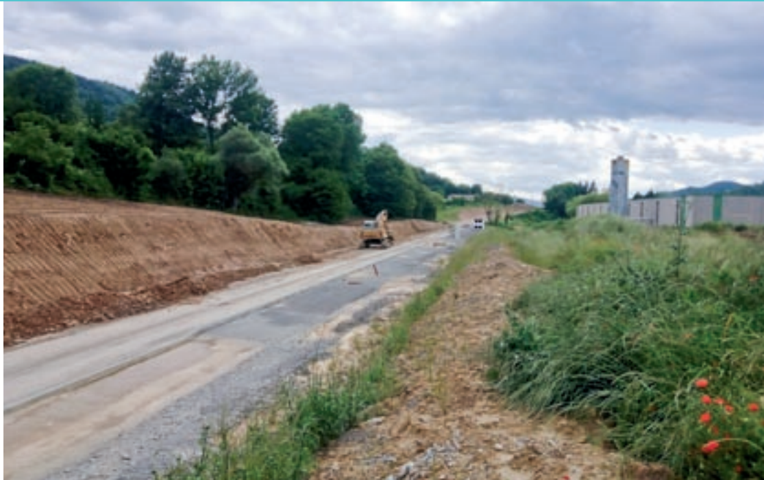
Estat actual de les obres del nou vial del polígon. Al fons, a la dreta, la nau més nova que va construir la tèxtil Llaudet
