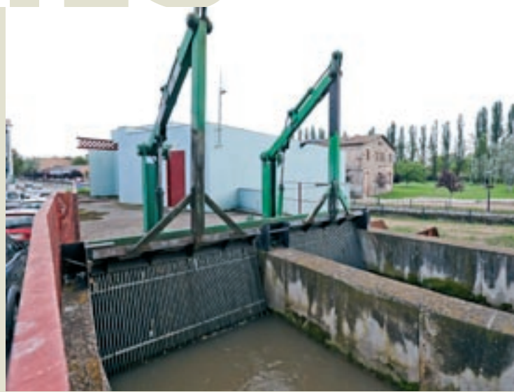
El canal industrial de Manlleu, a la zona de les Hortes
