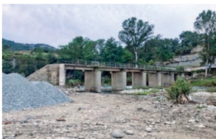
La reforma del pont de la Coromina, en marxa
