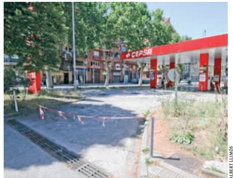
Vista de la gasolinera, que de moment continua tancada
