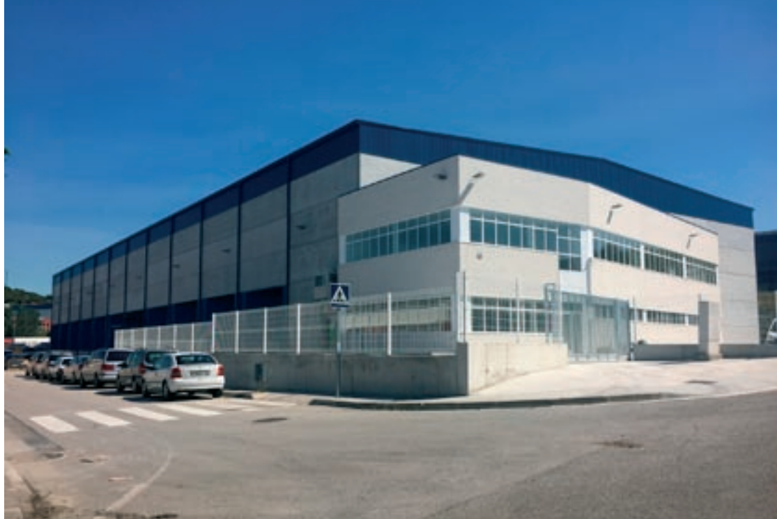
Les instal·lacions que acolliran l'ampliació de les activitats de Transparets a partir del mes d'agost
