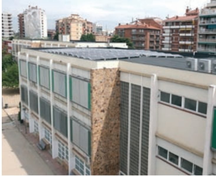
L'edifici antic de l'EMT per la façana de l'interior de l'illa
