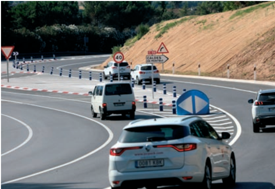
El nou vial permet als vehicles que van en direcció a Caldes seguir la marxa sense haver d'aturar-se a la rotonda
