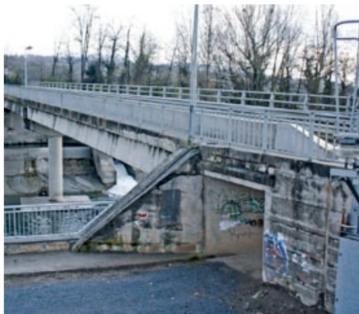
El pont de Montesquiu que travessa el riu Ter
