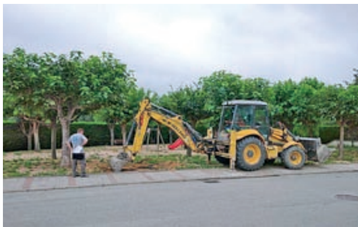
Una retroexcavadora, treballant aquesta setmana a les Masies de Roda
