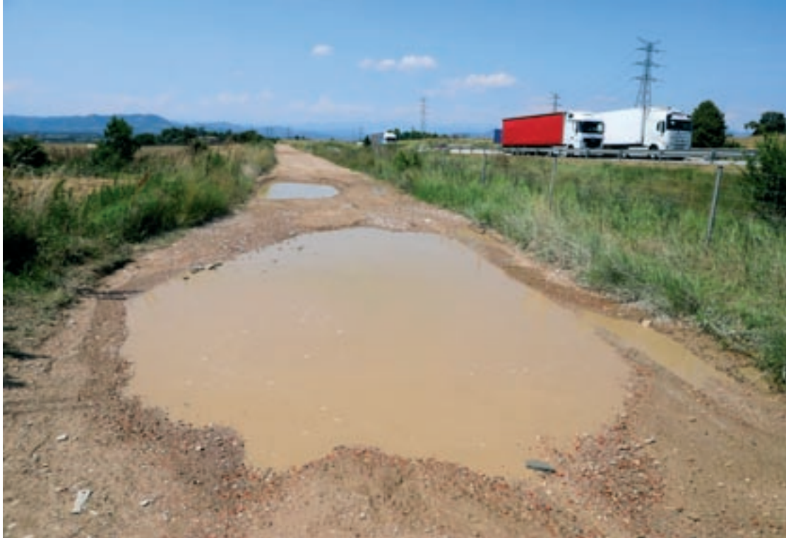
L'estat dels laterals de l'Eix ha empitjorat amb les últimes pluges
