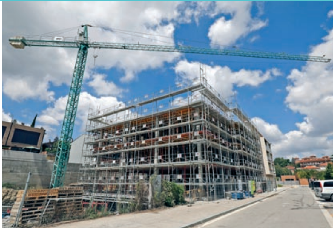
Estructura d'un edifici d'habitatges en construcció, aquest divendres a Vic
