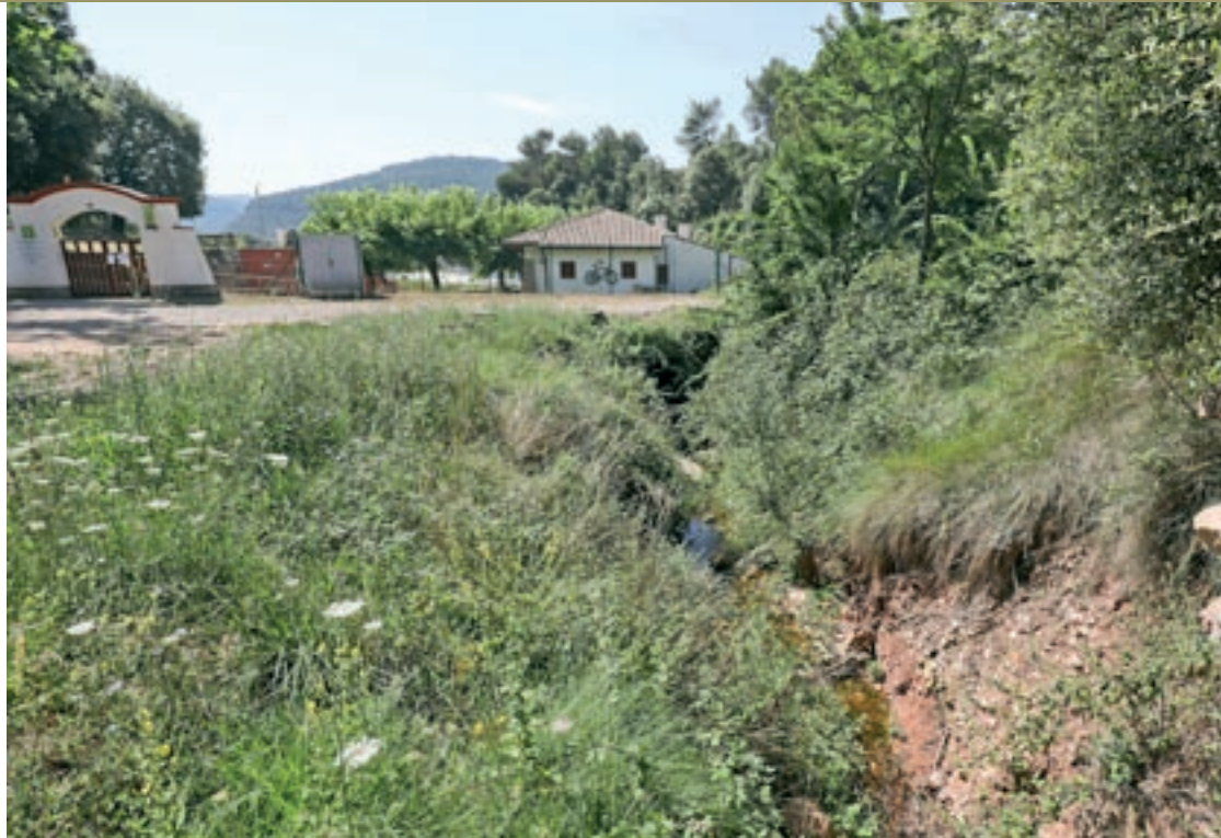
Estat en què es troba el torrent, encara canalitzat per sota de l'edifici on actualment hi ha el restaurant de l'Oller
