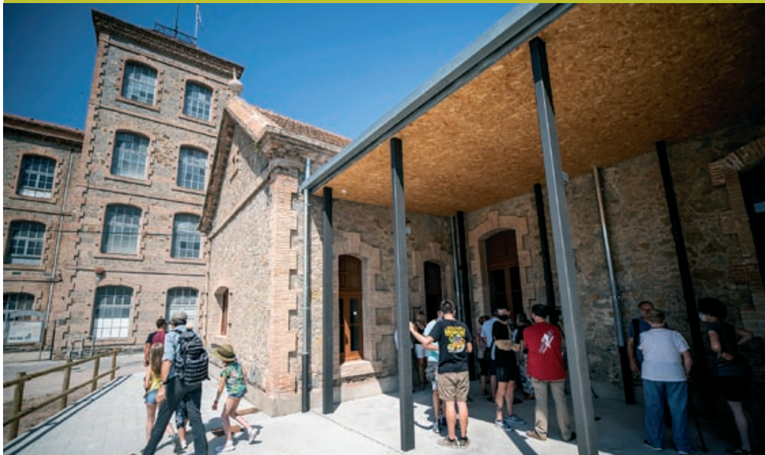
Els veïns de Borgonyà entrant diumenge al matí a la Casa del Metge. El porxo que s'hi ha fet al davant és de nova construcció, però no està ancorat a la façana
