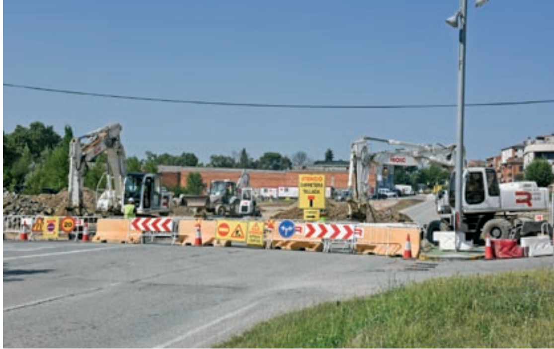
La rotonda es faria en aquest punt, que aquesta setmana s'ha tallat al trànsit per dur-hi a terme les obres del passeig
