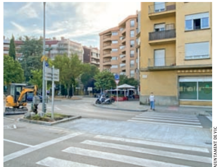
Al carrer Mossèn Josep Gudiol ja s'ha fet una primera intervenció
