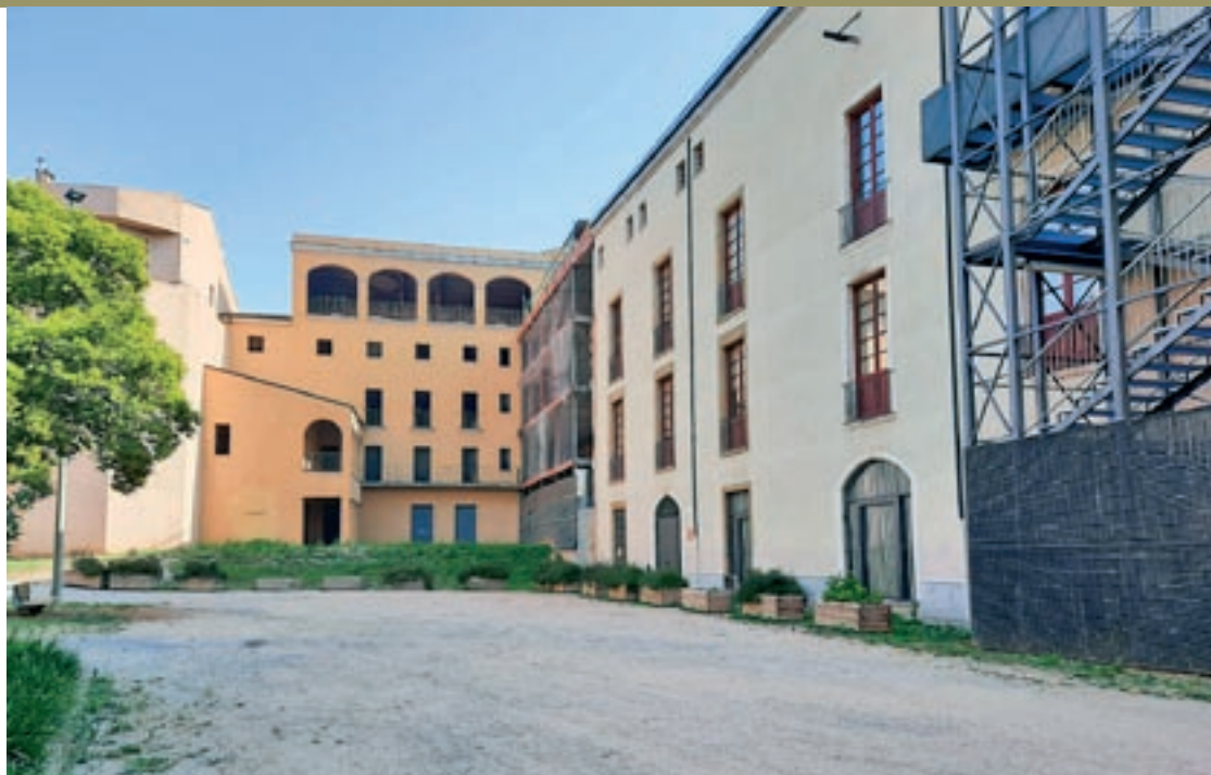
El parc Maria Àngels Anglada on es farà l'aparcament i al fons, l'edifici del Seminari que s'ha posat en venda
