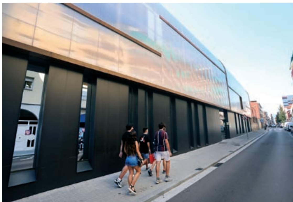
Les noves instal·lacions d'Estabanell al carrer Ponent de Granollers estan en funcionament des de fa uns mesos
