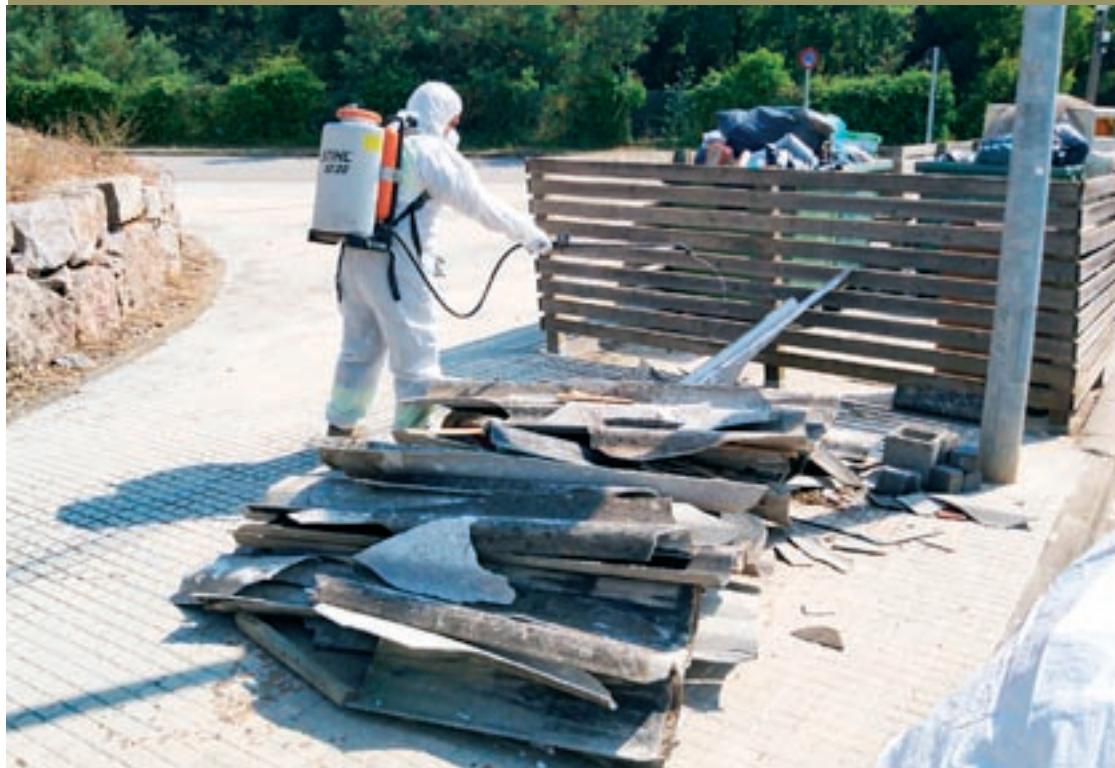
Treballs de retirada de plaques d'amiant i neteja de la via pública al barri de les Roquetes de Vilanova
