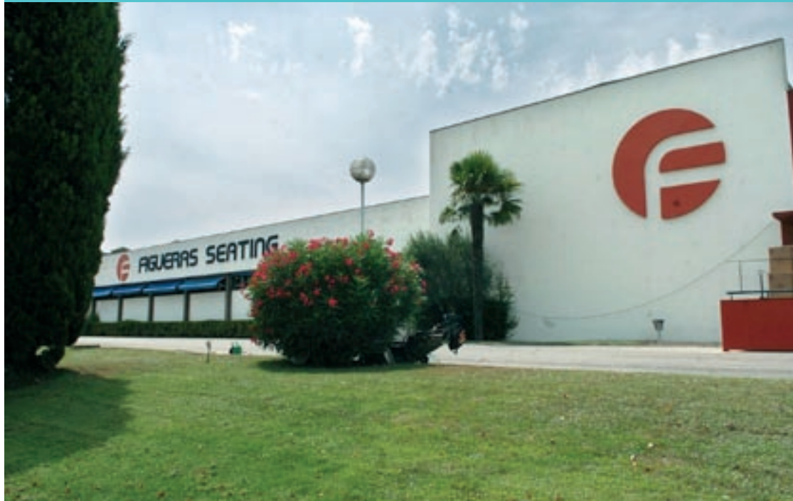
La planta de Figueras Seating a Lliçà d'Amunt
