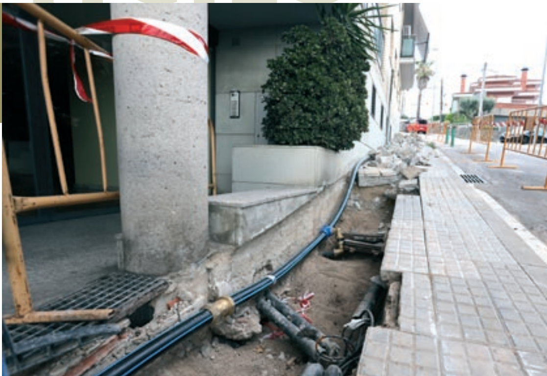
Les obres de renovació de la canonada del carrer Uruguai, aquest dimecres al matí
