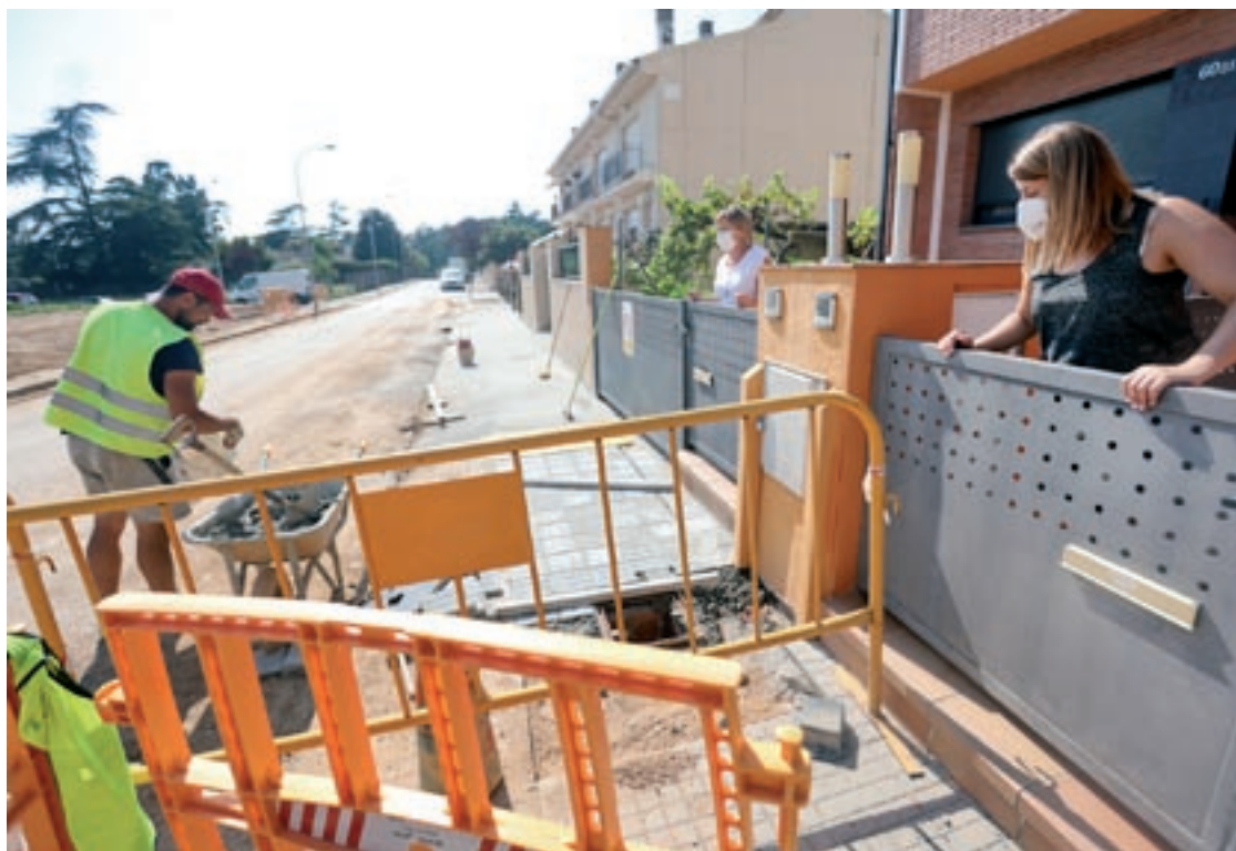
Lidia Martos, en primer terme i Maria Medina, es miren les obres de reparació, divendres passat
