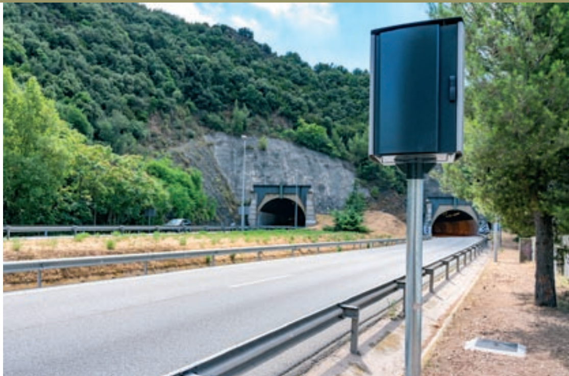
El radar està situat uns metres abans d'arribar al túnel de Figaró, a la part del darrere de la pista poliesportiva
