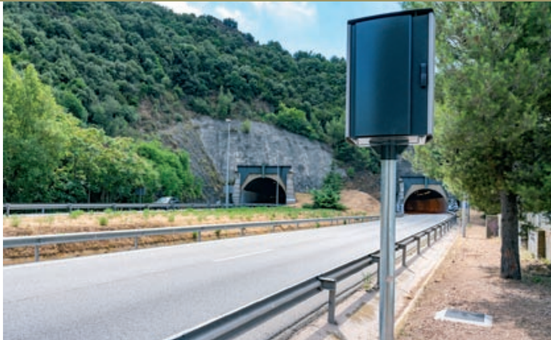
El radar està situat uns metres abans d'arribar al túnel de Figaró, a la part del darrera de la pista poliesportiva
