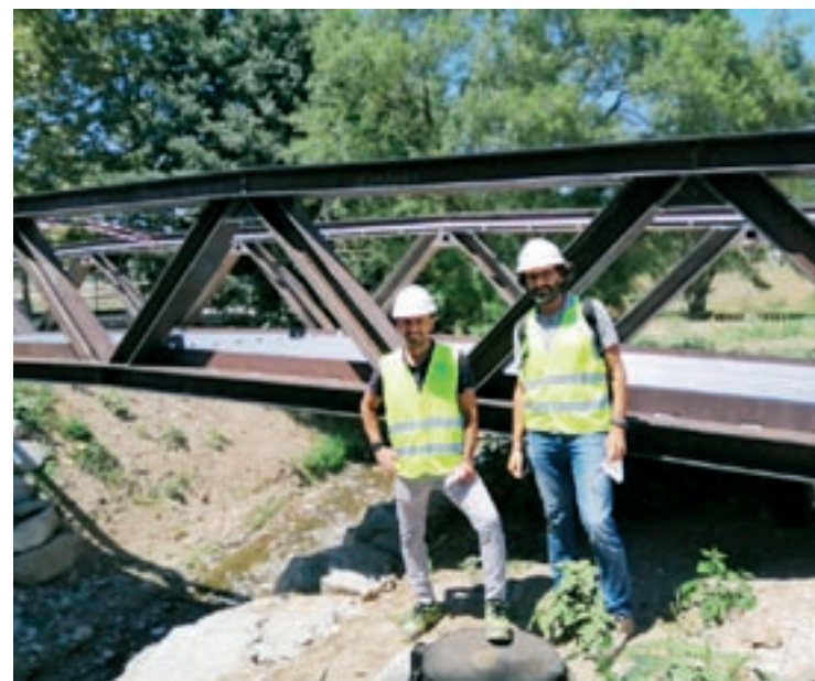
L'estructura metàl·lica s'ha col·locat aquest mes d'agost
