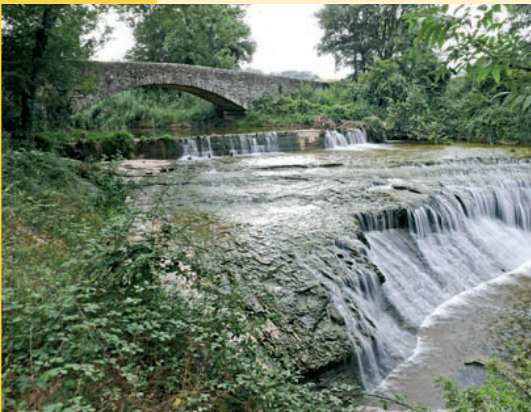
El pont de Torruella
