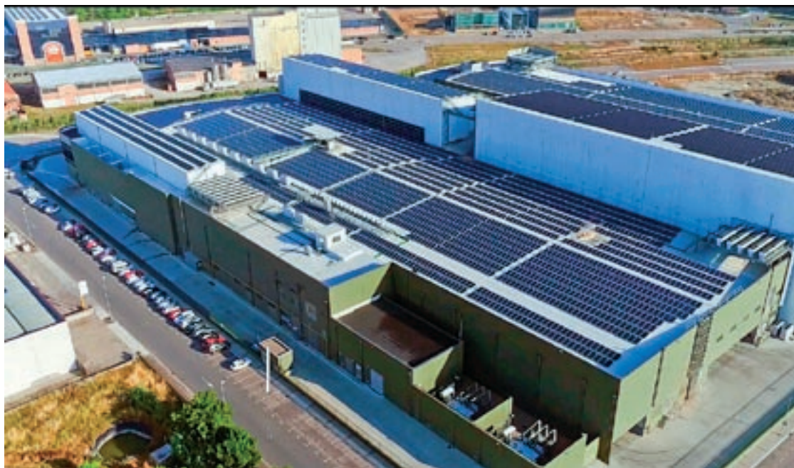
Imatge aèria de la seu central i fàbrica de Casa Tarradellas, a Gurb, tota folrada de plaques, al sostre i al lateral sud
