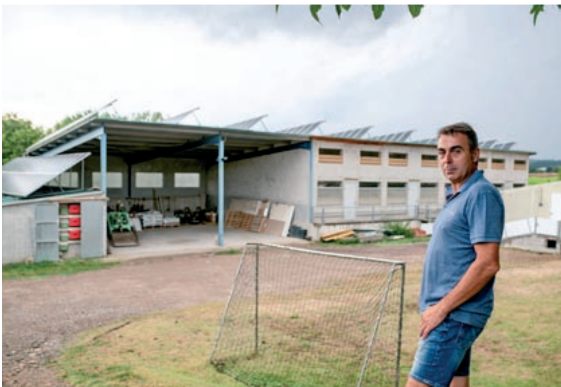
Jordi Camps, ramader, ha instal·lat plaques sobre la teulada de la granja que li faciliten l'energia directament
