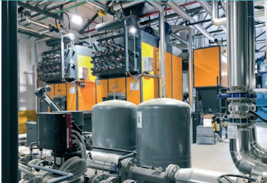
Quadpack ha posat en funcionament una planta de biomassa que es nodreix de les restes de la fusta que fa servir
