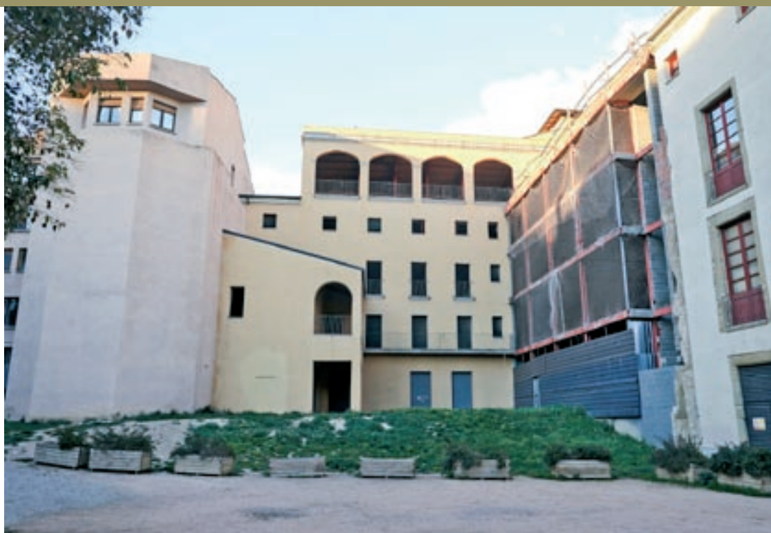
L'edifici té l'entrada pel parc Maria Àngels Anglada i limita per darrere amb els carrers Sant Miquel i Sant Just
