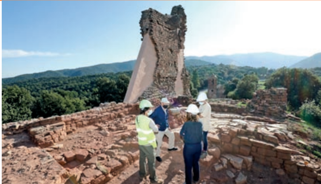
El castell del Brull, aquest dimarts en una visita d'obres. En primer terme, la part que s'ha tret al descobert
