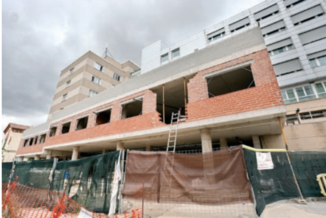
La futura nova àrea de malalts crítics permetrà al centre disposar de 10 llits més per a la UCI
