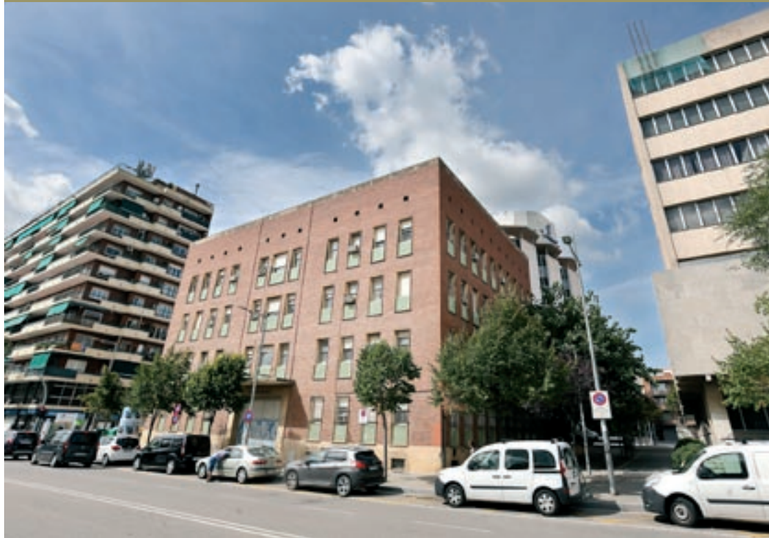
L'edifici judicial de l'avinguda del Parc està desocupat des de l'any 2010
