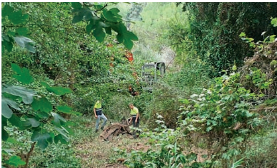
Els operaris i una excavadora treballaven divendres al migdia per retirar les restes de l'Opel Corsa de la llera
