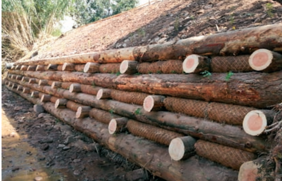
L'estructura construïda amb troncs d'abet Douglas i amb plantacions vegetals que afavoriran la consolidació del marge
