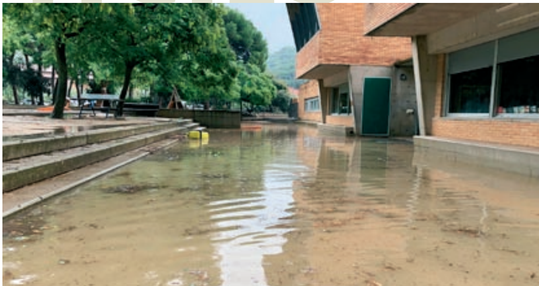
Part de l'aigua va entrar a l'interior de l'edifici des del pati on es va acumular un gran bassal
