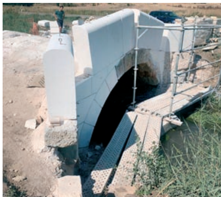
A l'esquerra, el pont de la Melgosa, a Conca, abans de la restauració. A la dreta els treballs de restauració en què s'han fet servir pedres calcàries, intentant recuperar el seu aspecte original
