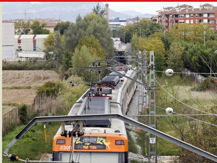
Un tren a la sortida del tram soterrat de la via, als Habitatges Montseny de Vic
