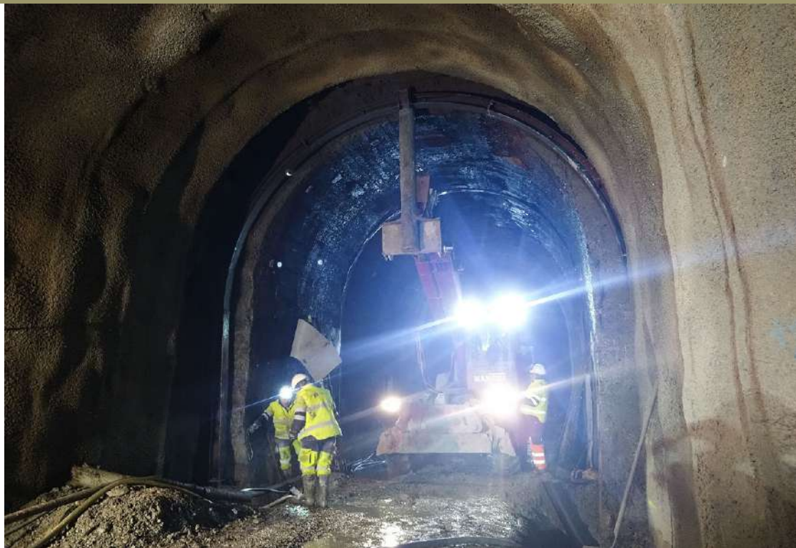
Operaris a l'interior del túnel de Toses, on s'està treballant per les dues bandes
