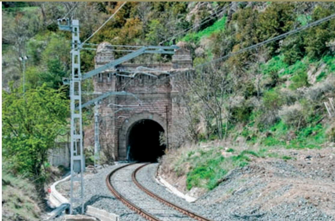
Vista de la boca sud del túnel de Toses el 2009, quan s'hi va fer la renovació de les instal·lacions ferroviàries
