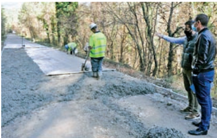
Colomer i Pérez, en una visita d'obres a la carretera de Ribamala
