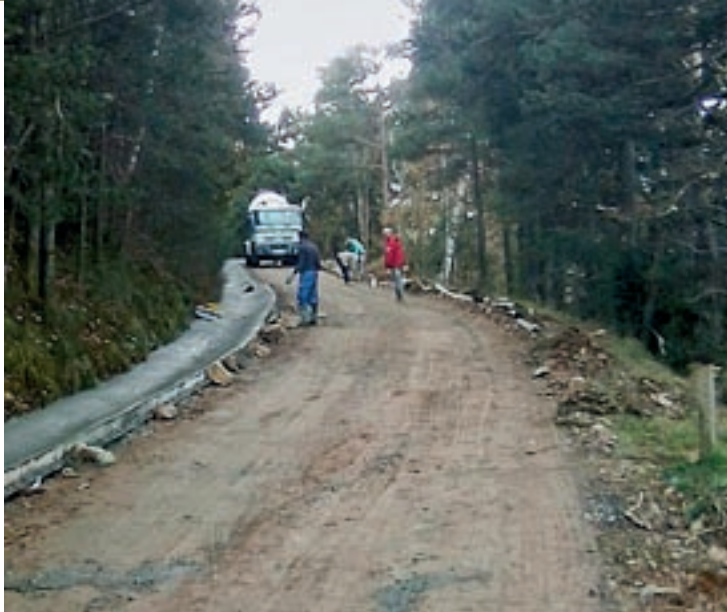
Operaris treballant en el camí de Ribes Altes a Tregurà
